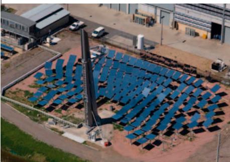
(d) 500 kW th solar tower, CSIRO, Newcastle, Australia
